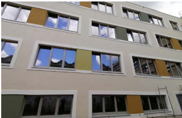
Außenfassade des Schulneubaus der Evangelischen Regelschule Gotha
