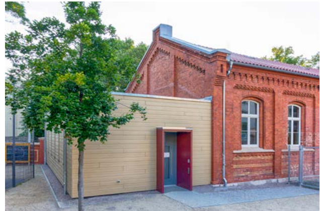
Sanierte Turnhalle der Evangelischen Grundschule Erfurt
